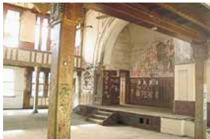
修復前の講堂
