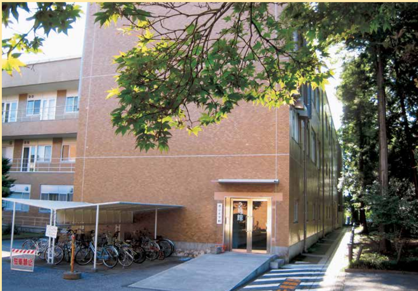
耐震改修された 2 号館 (旧 15 号館)、北側に小道も出来ました。
