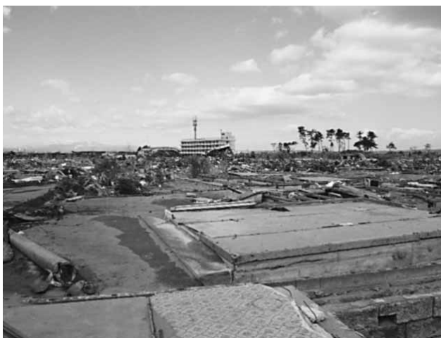
仙台市若林区荒浜地区 深沼橋
